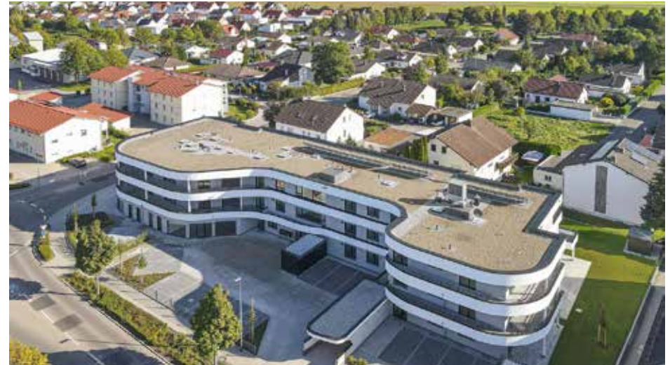
Untermeitingen · Lechfelder Straße
