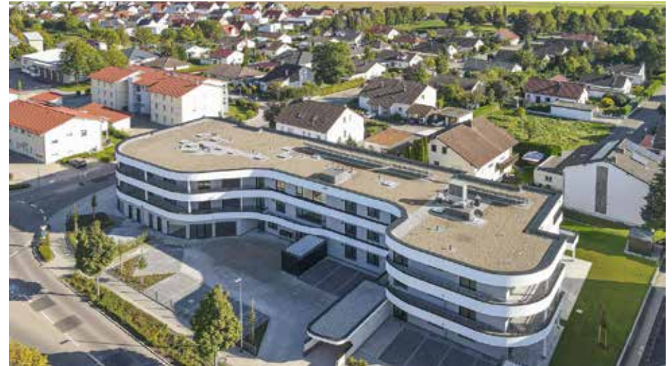
Untermeitingen · Lechfelder Straße
