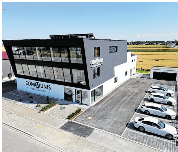
Architektonisch anspruchsvoll, modern und geräumig: so präsentiert sich der neue Firmensitz der Communis Projektbau GmbH.
