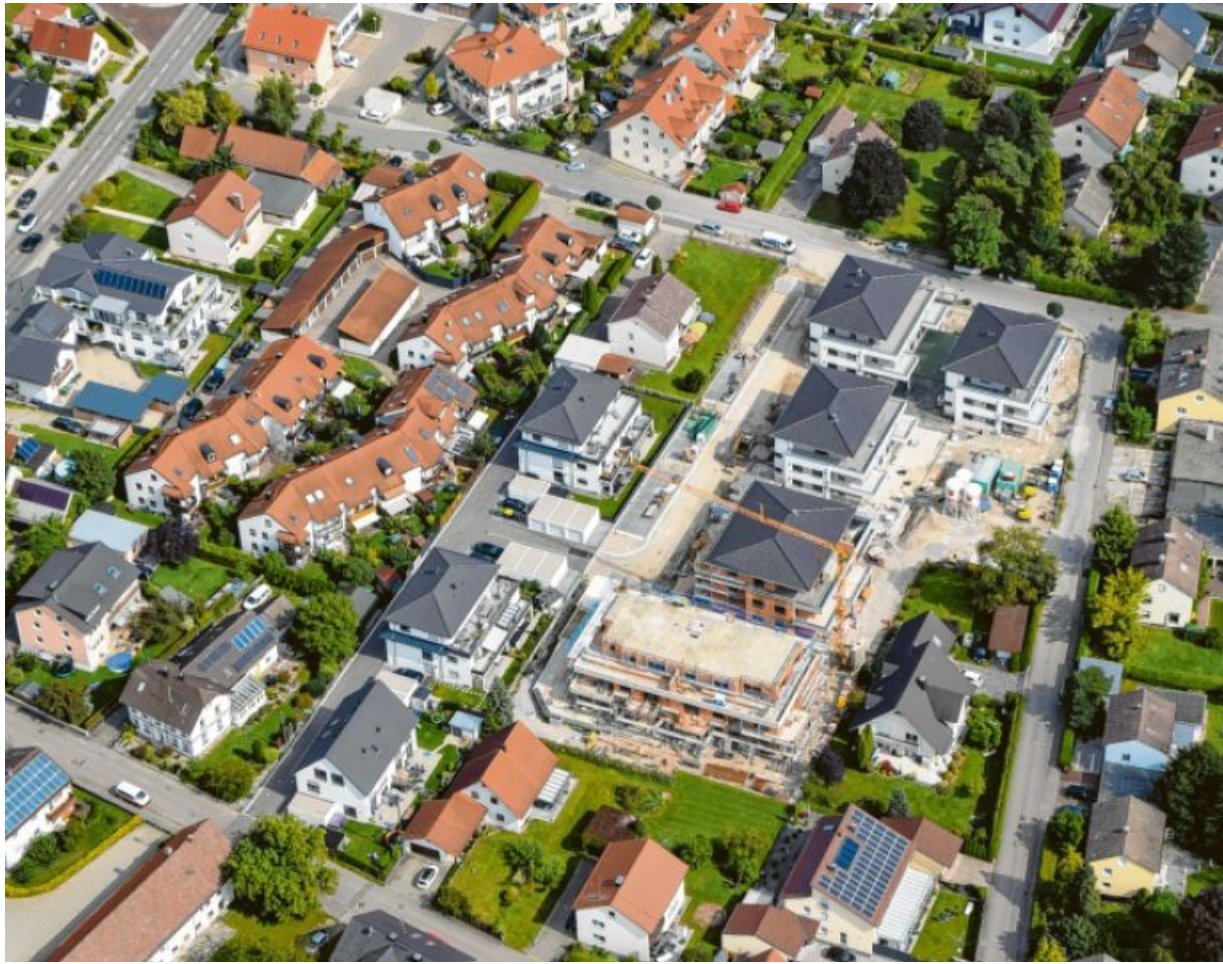
Mitte September befand sich die jetzt übergebene Straße (links neben den Neubauten) noch in der Entstehungsphase.
